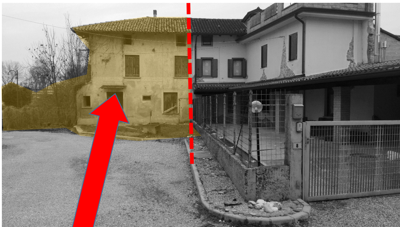
Edificio Soggetto a demolizione.
